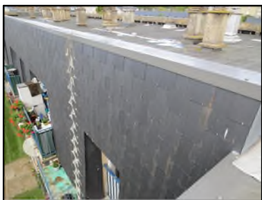
Photo N° 100 ECH-N°4 Toiture Terrasse Façade terrasse Ardoise noir
