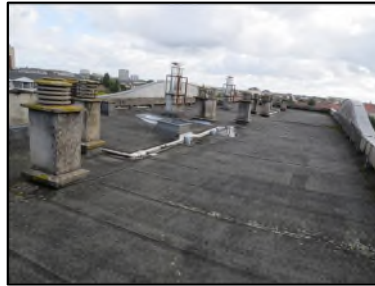
Photo N° 101 ECH-N°5 REVETEMENT DE SOL --Toiture Terrasse Planchers Bitume
