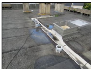
Photo N° 98 AMIANTE CIMENT Toiture Terrasse Conduits de ventilation Ventilation haute (Fibres- ciment)
