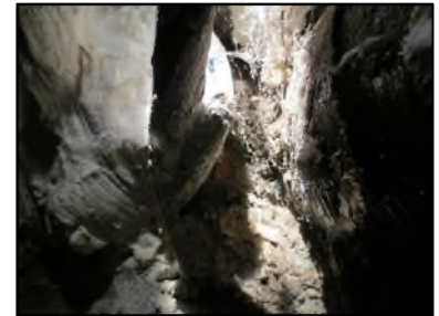
Photo N° 109 AMIANTE CIMENT Sous Sol Conduits Fourreau
