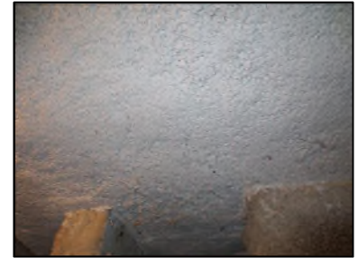
Photo N° 105 ECH-N°1 FLOCAGE Sous Sol Plafonds Cotonneux blanc
