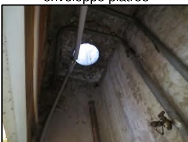
Photo N° 97 AMIANTE CIMENT Toiture Conduits de ventilation Ventilation haute (Fibres-ciment)
