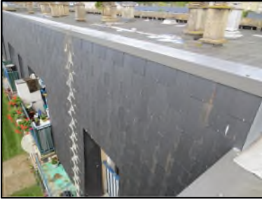
Photo N° 100 ECH-N°4 Toiture Terrasse Façade terrasse Ardoise noir
