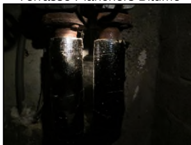
Photo N° 107 ECH-N°3 CALORIFUGEAGE --Sous Sol Conduits de fluide Liège + plâtre
