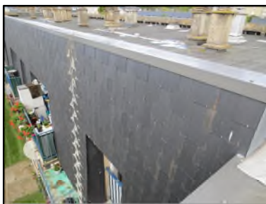
Photo N° 100 ECH-N°4 Toiture Terrasse Façade terrasse Ardoise noir
