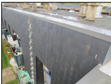
Photo N° 100 ECH-N°4 Toiture Terrasse Façade terrasse Ardoise noir
