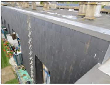
Photo N° 100 ECH-N°4 Toiture Terrasse Façade terrasse Ardoise noir
