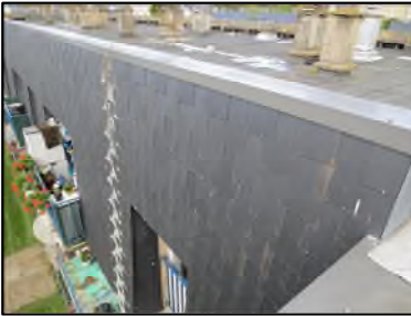
Photo N° 100 ECH-N°4 Toiture Terrasse Façade terrasse Ardoise noir
