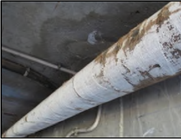
Photo N° 659 ECH-N°3 CALORIFUGEAGE --COULOIR DE CAVE Conduits de fluide Laine minérale + enveloppe plâtrée
