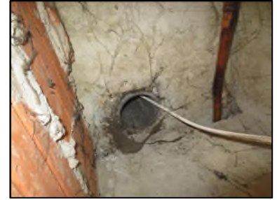
Photo N° 675 AMIANTE CIMENT -- Gaine technique 2 Conduits Ventilation haute (Fibres-ciment)
