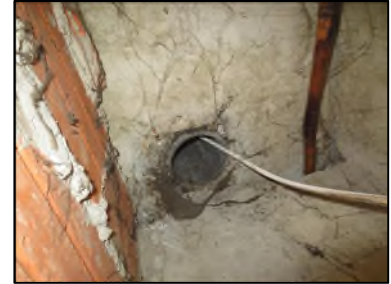
Photo N° 675 AMIANTE CIMENT -- Gain technique 2 Conduits Ventilation haute (Fibres-ciment)
