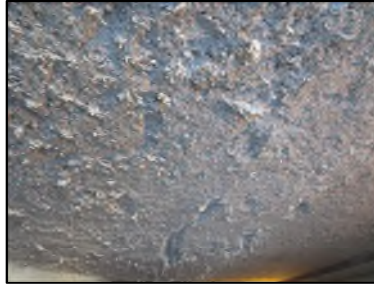
Photo N° 663 ECH-N°1 FLOCAGE -- COULOIR DE CAVE Plafonds Blanc cotonneux
