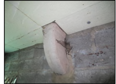
Photo N° 625 AMIANTE CIMENT -- Local objets encombrants Conduits de fluide Ventilation haute (Fibres- ciment)
