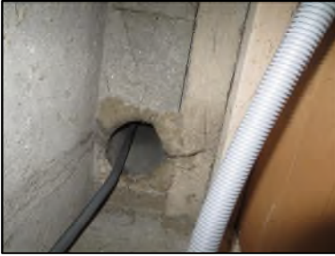
Photo N° 621 AMIANTE CIMENT -- Gaine technique gaz 2 Conduits de fluide Ventilation haute (Fibres- ciment)
