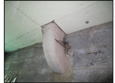
Photo N° 625 AMIANTE CIMENT -- Local objets encombrants Conduits de fluide Ventilation haute (Fibres- ciment)
