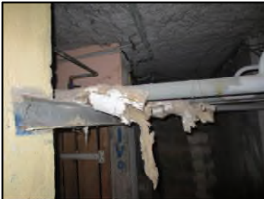
Photo N° 151 ECH-N°1 FLOCAGE Sous Sol Plafonds Flocage
