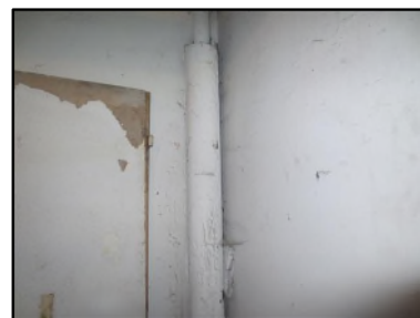
Photo N° 150 ECH-N°2 CALORIFUGEAGE Sous Sol Conduits de fluide Liège + plâtre
