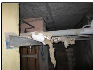
Photo N° 151 ECH-N°1 FLOCAGE Sous Sol Plafonds Flocage
