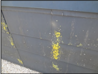
Photo N° 143 ECH-N°4 AMIANTE CIMENT Toiture Terrasse Murs Plaques planes (Fibres-ciment)
