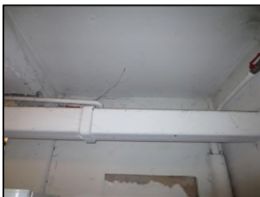
Photo N° 149 AMIANTE CIMENT Local Vélo RDC Gainés & coffres horizontaux Ventilation haute (Fibres-ciment)
