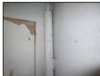
Photo N° 150 ECH-N°2 CALORIFUGEAGE Sous Sol Conduits de fluide Liège + plâtre
