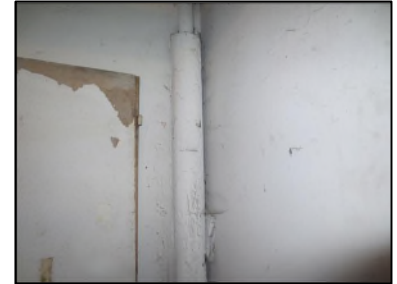
Photo N° 150 ECH-N°2 CALORIFUGEAGE Sous Sol Conduits de fluide Liège + plâtre
