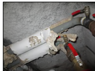
Photo N° 500 ECH-N°3 CALORIFUGEAGE --NC-COULOIR DE CAVE Conduits de fluide Laine minérale + enveloppe plâtrée
