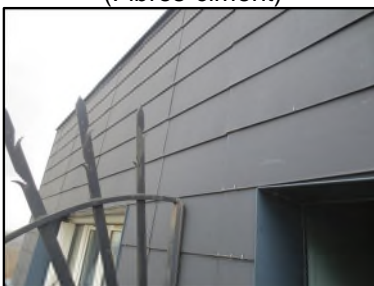
Photo N° 503 AMIANTE CIMENT -- FACADE Murs Bardage 40x40 (Fibres-ciment)
