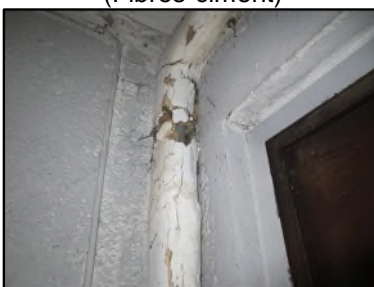
Photo N° 508 ECH-N°4 CALORIFUGEAGE --NC-LOCAL POUBELLE Conduits de fluide Laine minérale + enveloppe plâtrée
