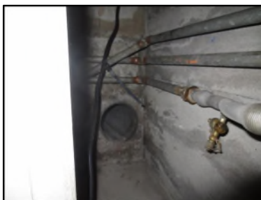
Photo N° 493 AMIANTE CIMENT -- Gaine Technique 17 Gainses & coffres verticaux Ventilation haute (Fibres-ciment)
