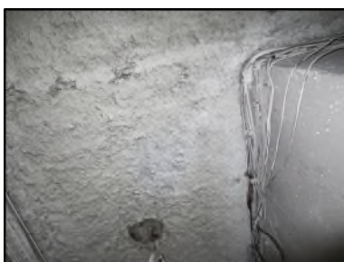
Photo N° 501 ECH-N°1 FLOCAGE COULOIR DE CAVE Plafonds Cotonneux
