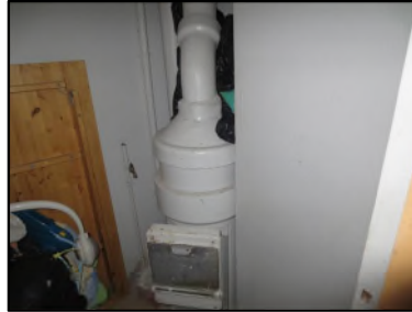
Photo N° 510 AMIANTE CIMENT -- PALIER VOLEE ESCALIER 1 au 16 Vide-ordures Gaine V.O.(Fibres- ciment)
