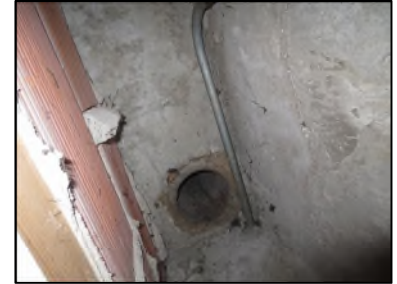
Photo N° 511 AMIANTE CIMENT - Gaine technique Gaz 15 & 16 Gaines & coffres verticaux Ventilation haute (Fibres-ciment)
