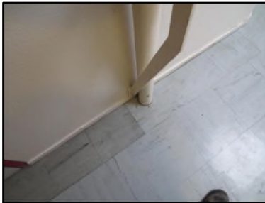
Photo N° 516 ECH-N°4 REVETEMENT DE SOL PALIER VOLEE ESCALIER 1 au 16 Planchers Dalles de sol 30x30 avec colle noire
