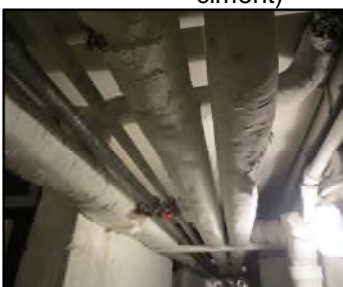
Photo N° 518 ECH-N°3 CALORIFUGEAGE COULOIR DE CAVI Conduits de fluide Laine minérale + enveloppe plâtrée
