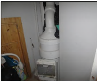
Photo N° 510 AMIANTE CIMENT --PALIER VOLEE ESCALIER au 16 Vide-ordures Gaine V.O.(Fibres- ciment)
