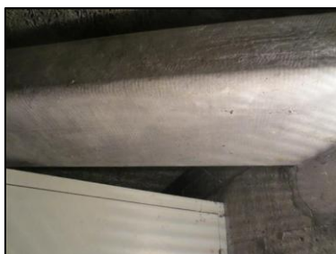
Photo N° 1207 AMIANTE CIMENT -- COULOIRS DE CAVES RDC Conduit Ventilation haute (Fibres- ciment)
