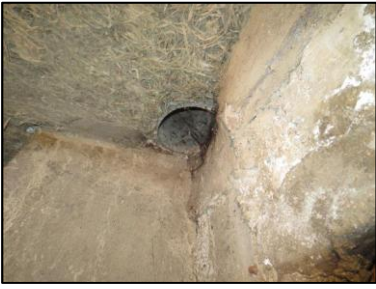
Photo N° 1206 AMIANTE CIMENT - -COULOIRS DE CAVES RDC Conduit Fourreau
