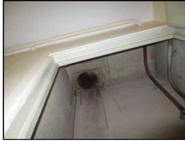
Photo N° 524 AMIANTE CIMENT -- PALIER VOLEE ESCALIER + 10 Gaines & coffres horizontaux Ventilation haute (Fibres-ciment)
