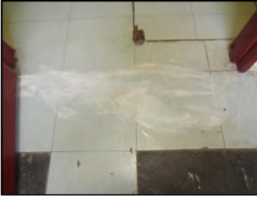
Photo N° 523 ECH-N°1 REVETEMENT DE SOL PALIER VOLEE ESCALIER 1 au 10 Planchers Dalles de sol 50x50 avec colle jaune
