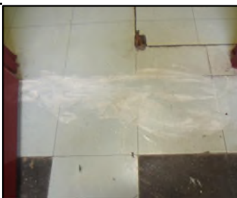
Photo N° 523 ECH-N°1 REVETEMENT DE SOL PALIER VOLEE ESCALIER 1 au 10 Planchers Dalles de : 50x50 avec colle jau
