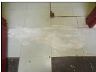
Photo N° 523 ECH-N°1 REVETEMENT DE SOL PALIER VOLEE ESCALIER 1 au 10 Planchers Dalles de sol 50x50 avec colle jaune
