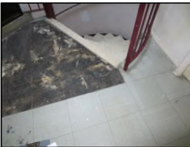
Photo N° 550 ECH-N°3 REVETEMENT DE SOL PALIER VOLEE ESCALIER 1 au 13 Planchers Dalles de sol 30x30 avec colle noire
