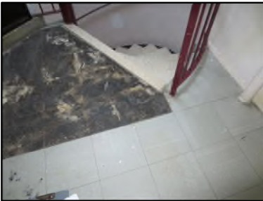
Photo N° 550 ECH-N°3 REVELEMENT DE SOL PALIER VOLEE ESCALIER 1 au 13 Planchers Dalles de sol 30x30 avec colle noire
