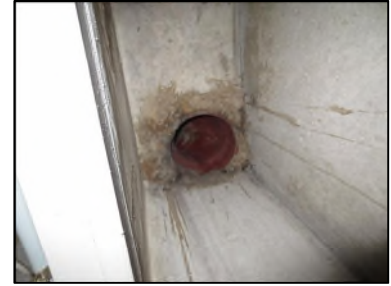
Photo N° 549 AMIANTE CIMENT -- NC-Gaine Technique 13 Conduits de ventilation Ventilation haute (Fibres- ciment)
