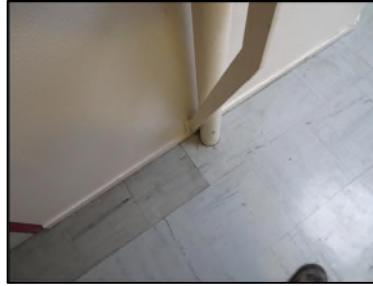
Photo N° 516 ECH-N°3 REVETEMENT DE SOL PALIER VOLEE ESCALIER 1 au 13 Planchers Dalles de sol 30x30 avec colle noire
