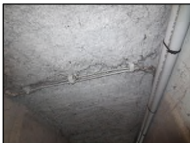
Photo N° 495 ECH-N°1 FLOCAGE - COULOIR DE CAVE_S.sol
