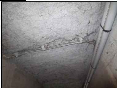
Photo N° 495 ECH-N°1 FLOCAGE - COULOIR DE CAVE_S.sol
