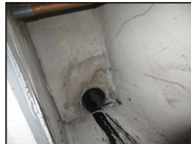
Photo N° 517 AMIANTE CIMENT -- NC-Gaine Technique 13 Conduits de ventilation Ventilation haute (Fibres- ciment)
