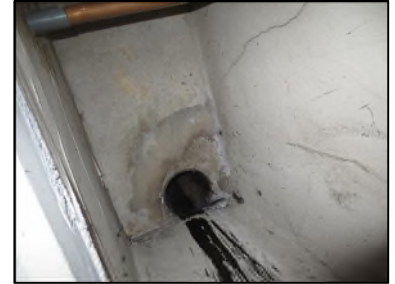
Photo N° 517 AMIANTE CIMENT -- NC-Gaine Technique 13 Conduits de ventilation Ventilation haute (Fibres- ciment)
