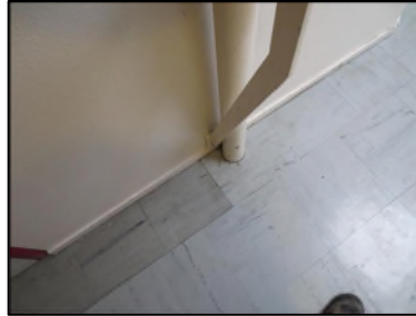
Photo N° 516 ECH-N°3 REVETEMENT DE SOL PALIER VOLEE ESCALIER 1 au 13 Planchers Dalles de sol 30x30 avec colle noire
