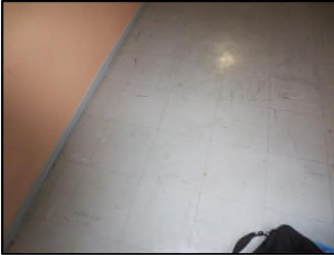
Photo N° 527 ECH-N°1 REVETEMENT DE SOL PALIER VOLEE ESCALIER +1 Planchers Dalles de sol 30x30 avec colle noire
