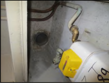
Photo N° 541 AMIANTE CIMENT -- Gaine technique 4 Gaines & coffres horizontaux Ventilation haute (Fibres-ciment)
