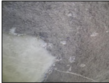
Photo N° 528 ECH-N°3 FLOCAGE SOUS SOL Plafonds FLOCAGE
