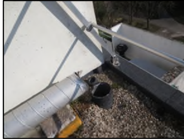
Photo N° 560 AMIANTE CIMENT TERRASSE Toiture Ventilation haute (Fibres-ciment)
