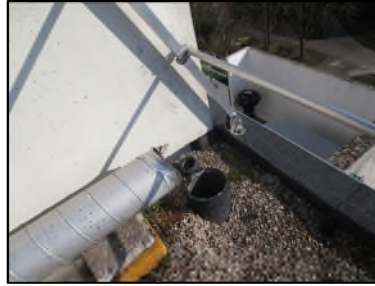
Photo N° 560 AMIANTE CIMENT TERRASSE Toiture Ventilation haute (Fibres-ciment)
