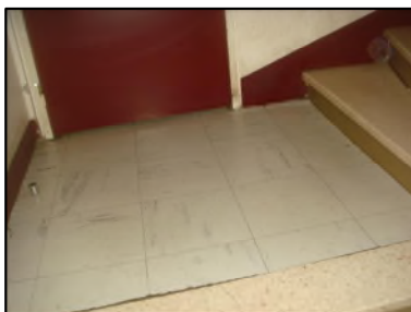
Photo N° 6085 ECH-N°1 REVETEMENT DE SOL --paliers +1 à +2 Planchers Dalles de sol 30x30 avec colle noir
