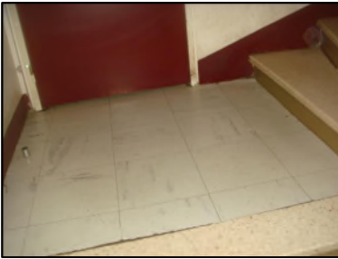
Photo N° 6085 ECH-N°1 REVETEMENT DE SOL --paliers +1 à +2 Planchers Dalles de sol 30x30 avec colle noir
