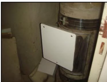
Photo N° 6054 AMIANTE CIMENT -- local vo -1 à +2 Vide-ordures Gainé V.O.(Fibres-ciment)
