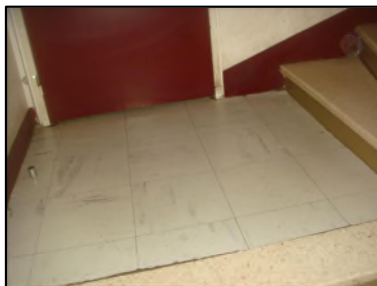
Photo N° 6085 REVETEMENT DE SOL --paliers +1 à +4 Planchers Dalles de sol 30x30 avec colle noire
