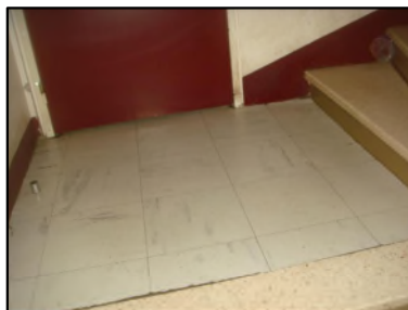
Photo N° 6085 REVETEMENT DE SOL --paliers +1 à +4 Planchers Dalles de sol 30x30 avec colle noire
